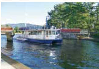
① 〈天橋立公園・廻旋橋〉 船が通るたびに90度旋回する珍しい橋 天橋立と文殊堂のある陸地をつなぐ橋。橋の下を通る大型船舶が増え、昭和35年に手動式から電動式へ変わりました。 ◎見学自由
